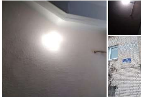
02.02.2021 ⚡ Восстановление освещения в парадной г. Пушкин, Школьная ул. д. 23 #жкс2пушкин #светремонтжкс2
