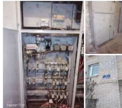
02.02.2021 ⚡ Ремонт ГРЩ г. Пушкин, Школьная ул. д. 23 #жкс2пушкин #ремонтгрщжкс2
