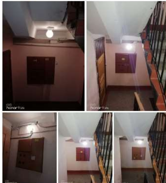
03.03.2021 Восстановление освещения в парадной, замена светильников, г. Пушкин, Школьная ул. 23 #жкс2пушкин
