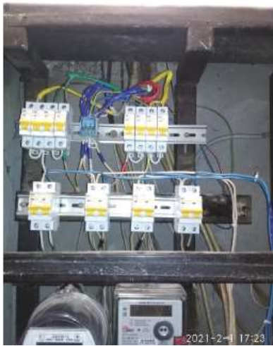
01.02.2021 ⚡ Ремонт распределительного щита г. Пушкин, Октябрьский б-р, д. 41 #жкс2пушкин
