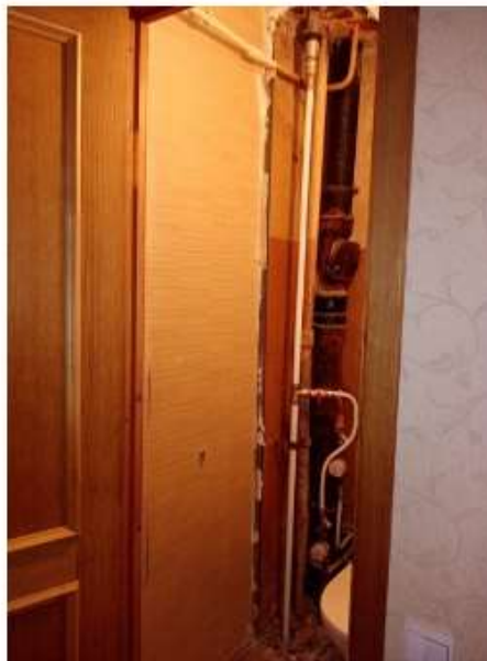
03.03.2021 Замена стояка ХВС в квартире г. Пушкин, Школьная ул. д. 23 #жкс2пушкин
