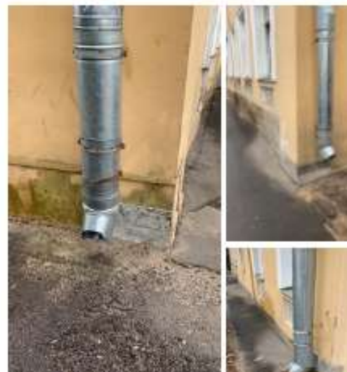
21.04.2021 🛠️ Ремонт водосточных труб г. Павловск, Средняя ул. д. 26/8 #жкс2пушкин
