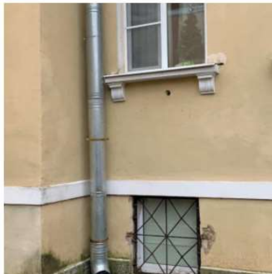
21.04.2021 🛠️ Ремонт водосточных труб г. Павловск, Госпитальная ул. 28 #жкс2пушкин
