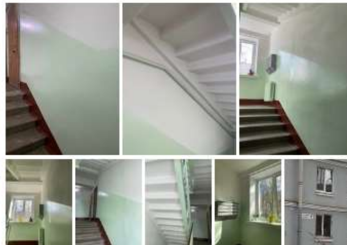
14.04.2021 Косметический ремонт лестничных клеток г. Павловск, Слуцкая ул. д. 6 пар 2 #жкс2пушкин
