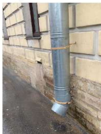
21.04.2021 🛠️ Ремонт водосточных труб г. Павловск, Оранжевая ул. д. 6/17 #жкс2пушкин
