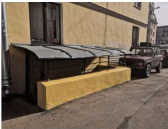
Восстановление штукатурного и окрасочного слоев фасада МКД г. Пушкин, Ленинградская ул. д. 8 #жкс2пушкин
