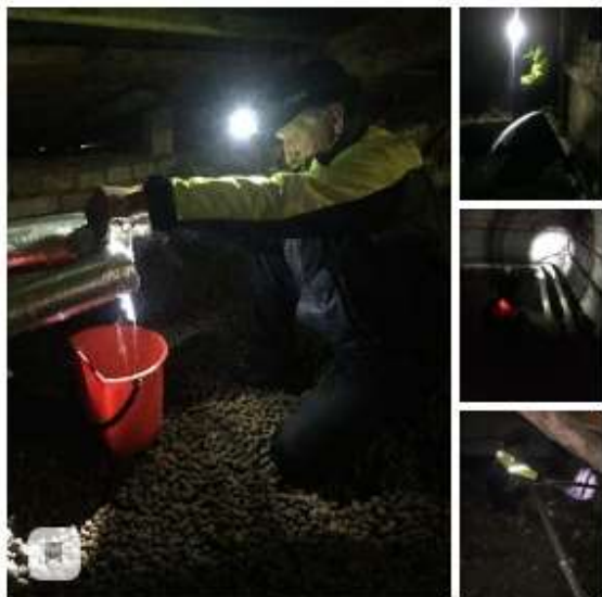
16.10.2020 г. Павловск, Толмачева ул. д. 9 Ликвидация воздушных пробок на стояке ЦО.
