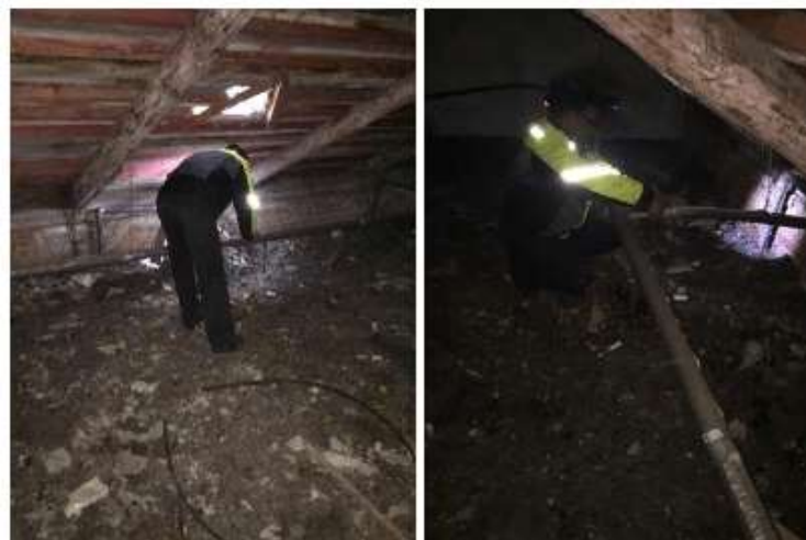
16.10.2020 г. Пушкин, Лебединая ул. 14/3 Ликвидация воздушных пробок на стояке ЦО.
