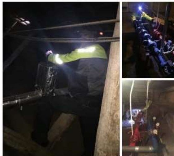
16.10.2020 г. Павловск, Березовая ул. д. 8 Ликвидация воздушных пробок на стояке ЦО.
