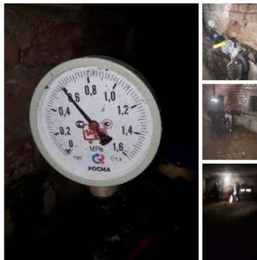
16.10.2020 г. Пушкин, Октябрьский б. д.48 выполнены работы по установке запорной арматуры д.50
