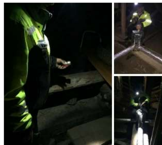
16.10.2020 г. Павловск, Лебединая ул. д. 16 Ликвидация воздушных пробок на стояке ЦО.
