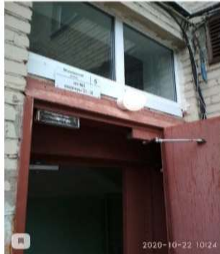
22.10.2020 Восстановление освещения г. Пушкин, Московская ул. д. 5
