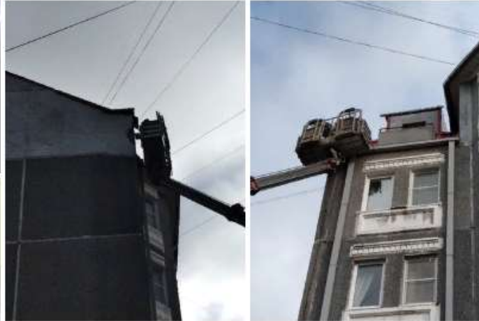
20.10.2020 Ремонт кровли г. Пушкин, Саперная ул. д. 50
