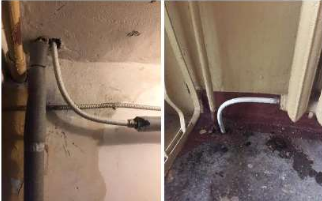
22.10.2020 Замена стояка ЦО в парадной г. Павловск, 1-я Советская ул. д. 16
