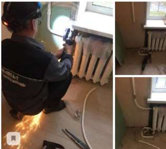
23.10.2020 Замена аварийного участка стояка ЦО г. Павловск, Гуммолосаровская ул. д. 11-3
