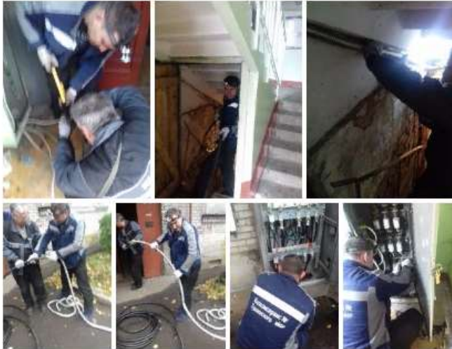
20.10.2020 Замена кабеля и ремонт ГРЩ г. Павловск, Мичурина ул. д. 28
