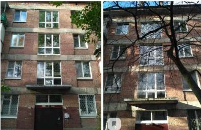
21.10.2020 Установка окон ПВХ г. Пушкин, Ахматовская ул. д. 3
