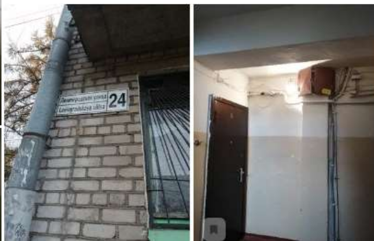
29.10.2020 Восстановление освещения в парадной г. Пушкин, Ленинградская ул. д. 24
