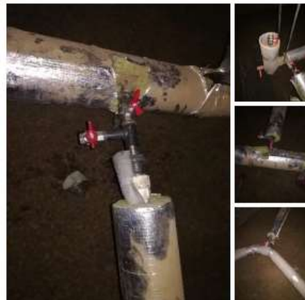
28.10.2020 Восстановление ЦО, замена вентиля г. Пушкин, Октябрьский б-р.
