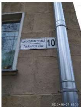
27.10.2020 Восстановление освещения г. Пушкин, Церковная ул. д. 10
