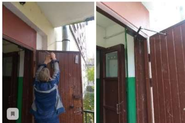
26.10.2020 Ремонт доводчика г. Пушкин, Ленинградская ул. д. 57 пар 4.
