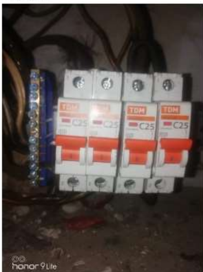
05.04.2021 Ремонт этажного эл/щитка г. Павловск, Толмачева ул. д. 8 #жкс2пушкин
