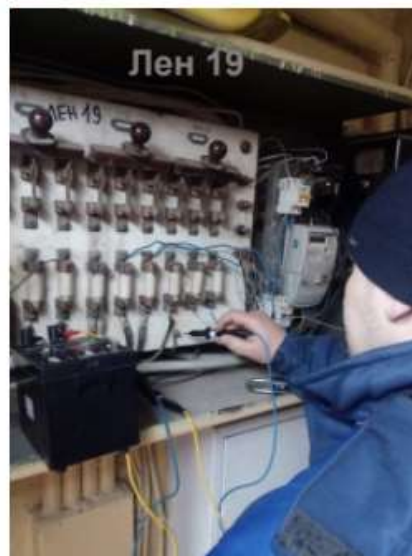
21.04.2021 Замер сопротивления изоляции г. Пушкин, Ленинградская ул. д. 19 #жкс2пушкин
