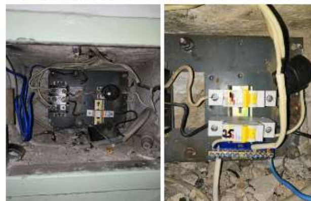
06.04.2021 г. Павловск, Обороны ул. д. 2 пар. 3 ремонт Эл/щитка с заменой автоматов.
