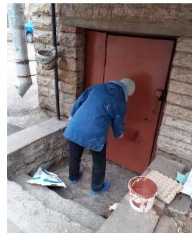
05.04.2021 Окраска подвальной двери г. Пушкин, ул. Конюшенная д. 37 #жкс2пушкин
