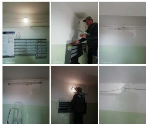
20.04.2021 Установка светодиодных светильников г. Павловск, Динамо #жкс2пушкин #светремонтжкс2
