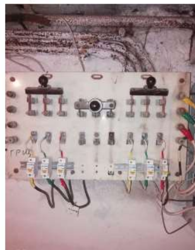
16.04.2021 г. Павловск, ул. Васенко д.11/6 ремонт ГРЩ #жкс2пушкин
