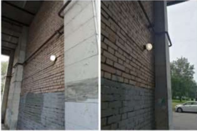
02.09.2020 Установка светильника в арке на фасаде МКД по адресу: г. Пушкин, Школьная ул. д. 23
