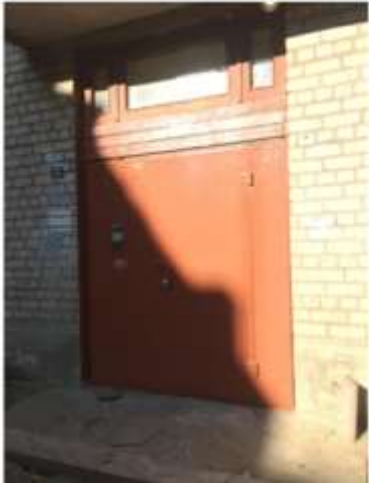
23.09.2020 Окраска входной двери г. Пушкин, Церковная ул. д. 19
