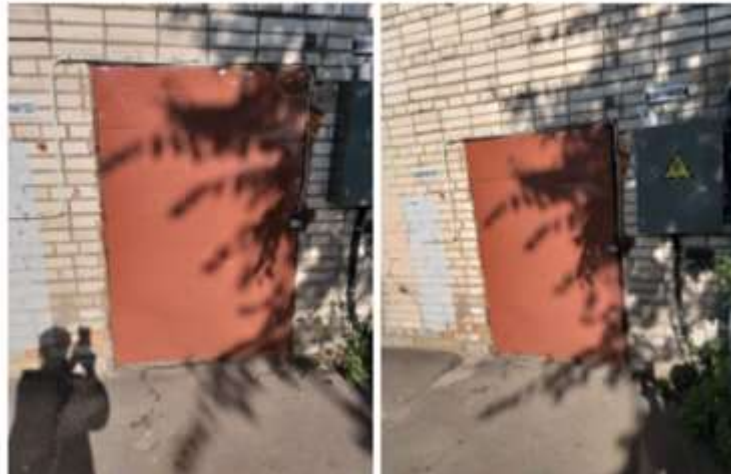
23.09.2020 Окраска подвальной двери
