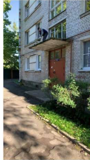
15.09.2020 г. Павловск, Мицурина ул. д.28 очистка козырьков от мха.
