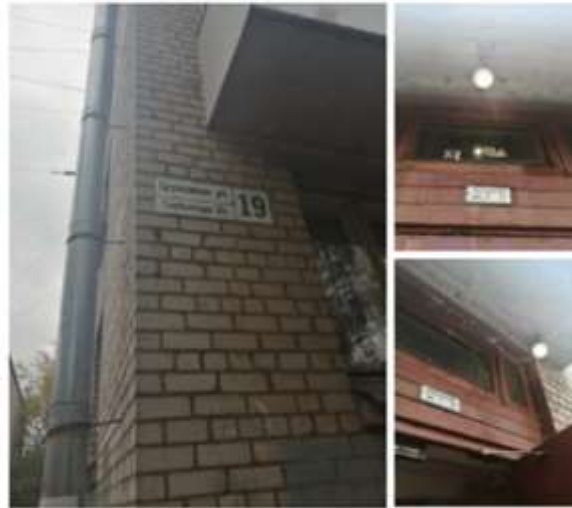
22.09.2020 Восстановление освещения г. Пушкин, Церковная ул. д. 19
