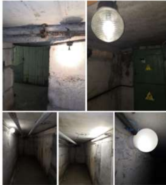
04.09.2020 г. Павловск, Динамо, Пионерская ул. д. 13 восстановление освещения.
