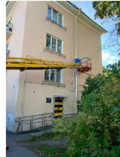
14.09.2020 г. Пушкин, Московская ул. д. 29 окраска водосточных труб.
